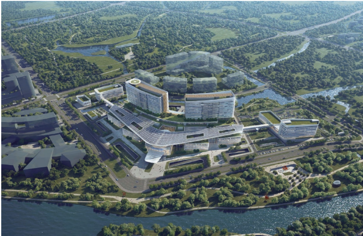
嘉兴市第二医院整体迁建工程（长三角国际医学中心总医院）
